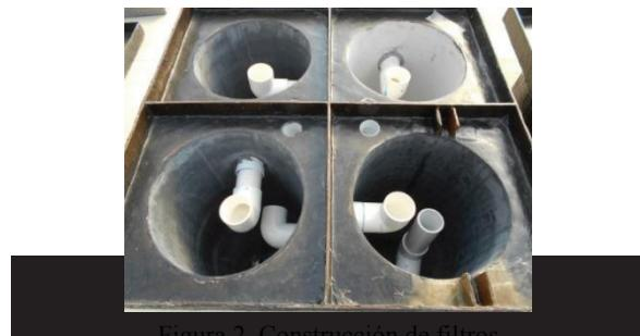
Figura 2. Construcción de filtros
